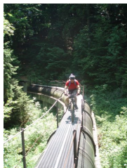
Une conduite forcée
